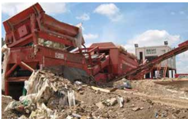
Planta de reciclado de escombros de Sani en Almendralejo, España.
