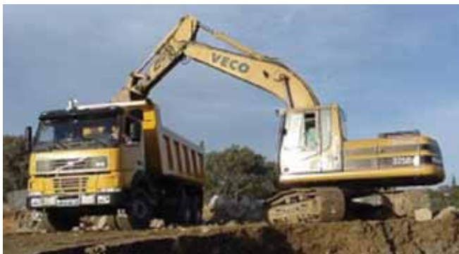
Manipulación de escombros
