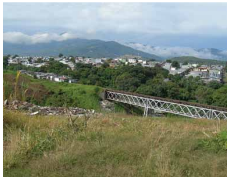
Escombros de construcción lanzados a orillas del Río Torres.
